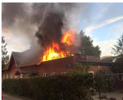
Billede 1. Der er ild i et ældre hus, i 1½ etage med udnyttet kælder. Kraftig røgdudvikling ud fra gavl i bygning, som er sammenbygget med garage. Foto : Bjørn Nielsen, www.bpln.dk
