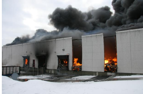
Billede 2. En brandsektion på 2.000 kvadratmeter med lagerafsnit for brandbare materialer er overtændt, og branden er brudt igennem taget. Der er risiko for brandspredning til andre brandsektioner, som er bygget sammen med lagerafsnittet. Foto; Kalle Karlsson.
