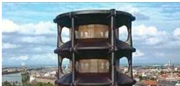
Sirenevarslingsystemet kan tages i brug ved større ulykker eller katastrofer.
