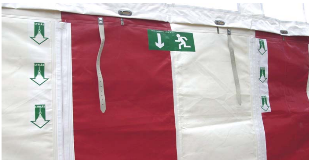
Figur 4 Eksempel på afmærkning af udgang forsynet med lynlås.
