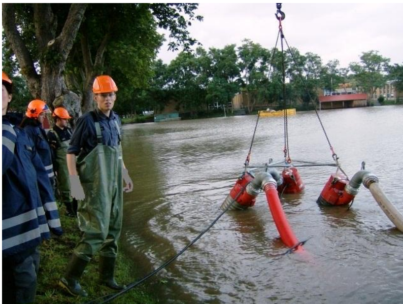
Læsepumper i brug ved oversvømmelse
