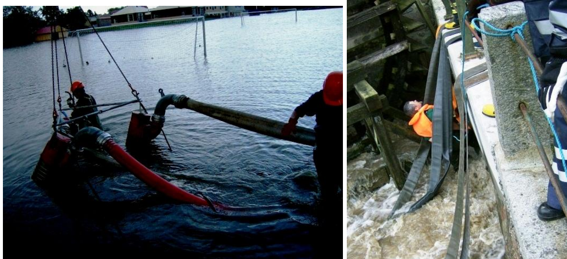
Mandskabet iført waders ved arbejde ifm. oversvømmelse
