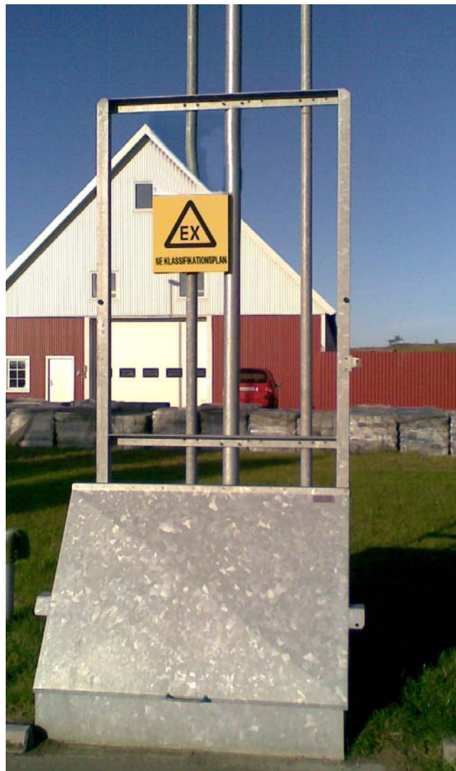
Figur 2: Eksempel på EX-skiltning af udluftningsrør og påfyldningsplads.
