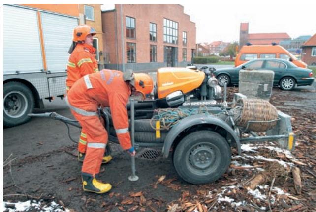
Pumpen løftes til vandret stilling
